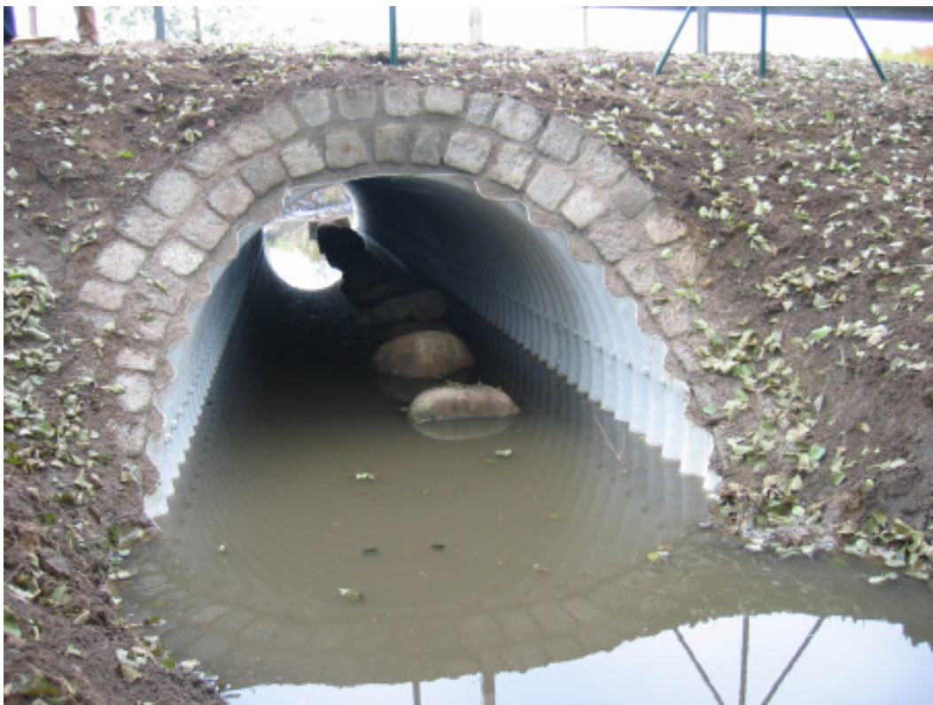
Foto 6: Hamco Rohr nach Einbringung in den Straßenkörper. Trittsteine dienen dem Otter zur Unterquerung der Straße
