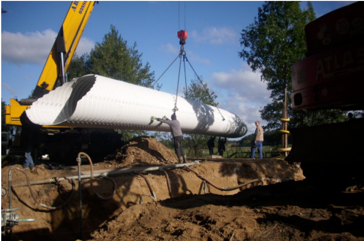
Foto 4: Einbau des Hamco-Rohres
