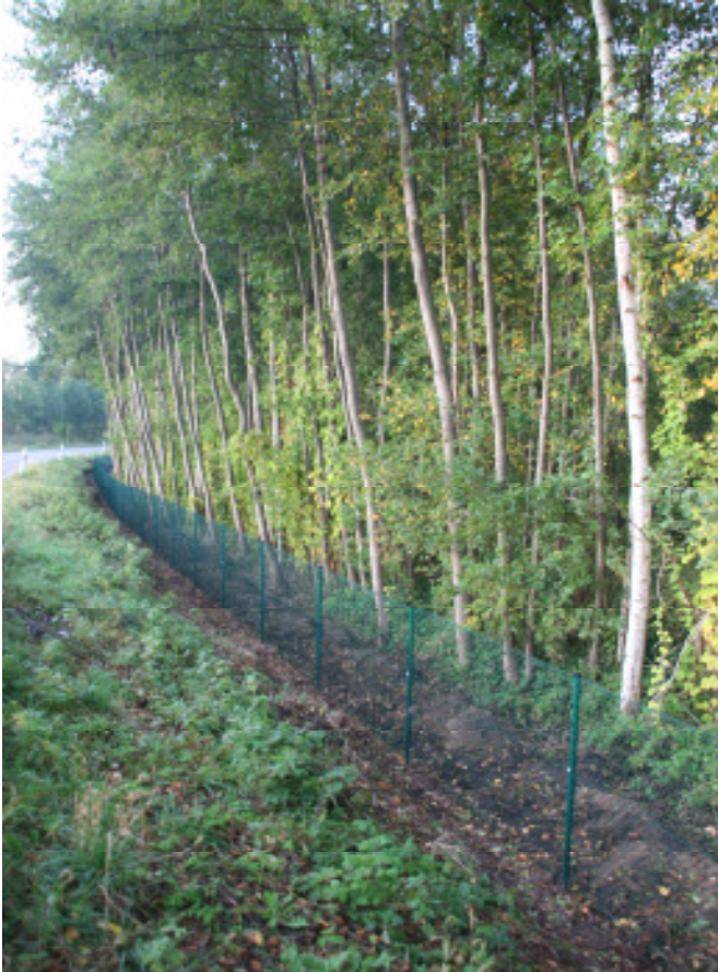
Foto 5: Um den Otter zum Tunnel zu leiten wurden 350 m Maschendrahtzaun errichtet.
