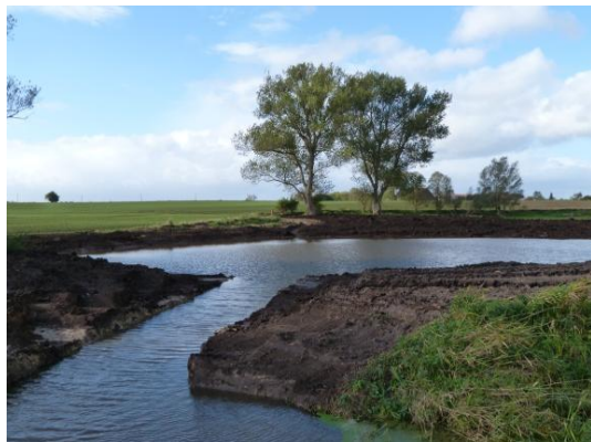
Anlage eines Kleingewässers mit Verbindung zum Altlauf der Schilde
