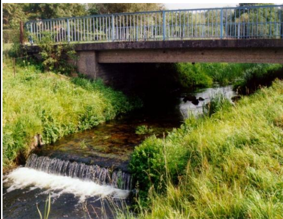
Sohlabsturz vor dem Umbau
