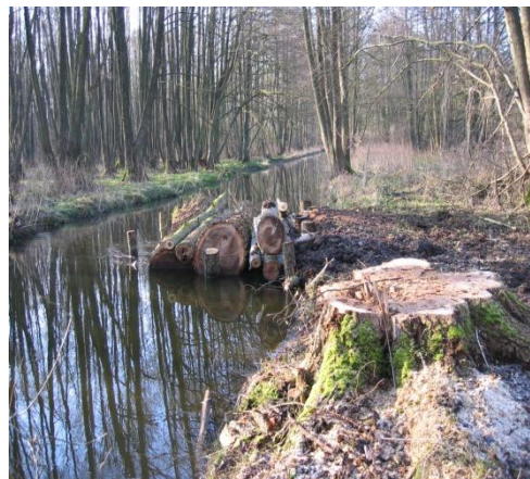
Einbau von Störelementen
