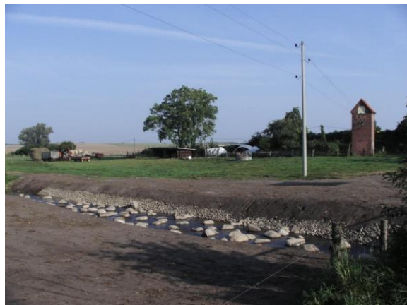
Fischtreppe nach Fertigstellung
