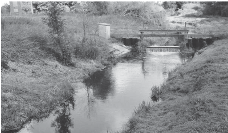
Durch das Wehr bei Karft wird die ökologischen Durchgängigkeit der Schilde unterbrochen. Es ist geplant das Wehr zurückzubauen und durch eine Fischaufstiegsanlage zu ersetzen.
