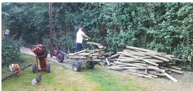
Beginn Bauarbeiten Klocksdorf_H_Schuetze.jpg
