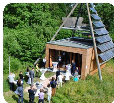
Im Juni 2021 wurde unter der Solarpyramide hinter dem PAHLHUUS der neue Bildungspavillon eröffnet. Er wird für Bildungsveranstaltungen des Biosphärenreservatsamtes genutzt.
