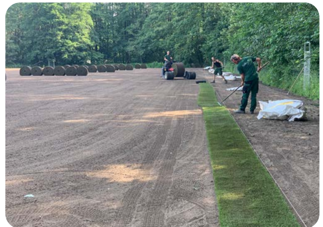
Auch der angrenzende Sportplatz war in das Projekt eingeschlossen. Der Platz wurde saniert und mit neuem Rollrasen versehen.
